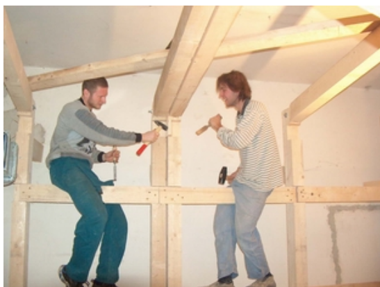
Konstrukce boulder stěny
